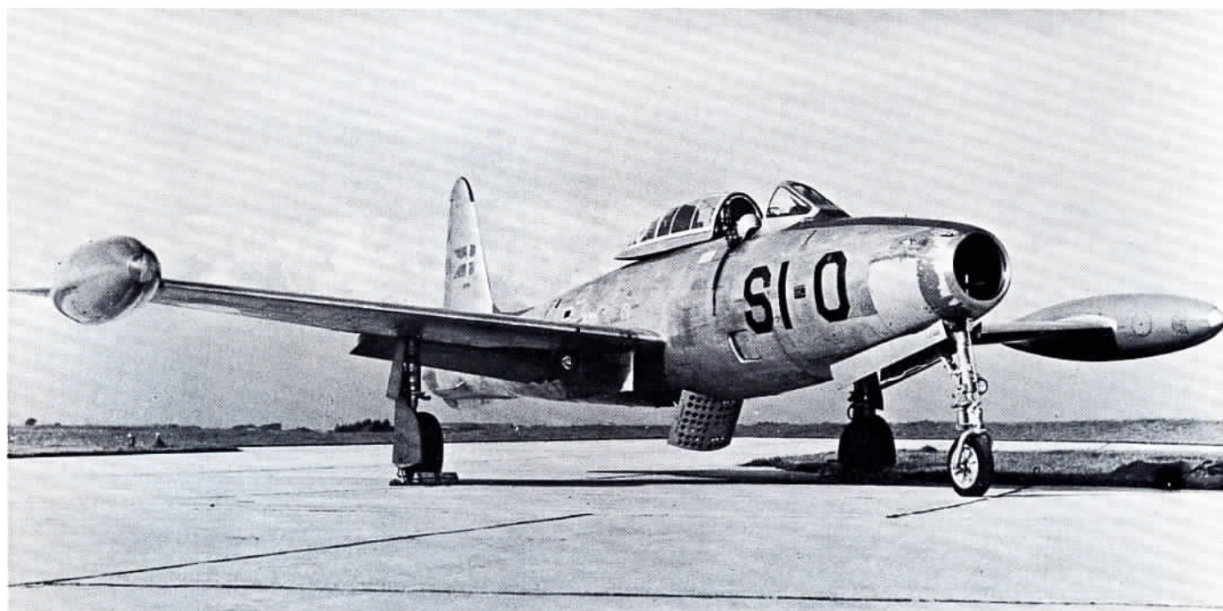
Også dette billede af SI-O, 51-10718, syntes vi viste nogle af F-84Gs karakteristika, - det lange forstærkede canopy, tiptankene, understellet med den store sporvidde, det spinkle næsehjulsen og den udfældede speedbrake med de mange huller. De første F-84ere havde i øvrigt kun fire rektangulære huller i speedbrake
